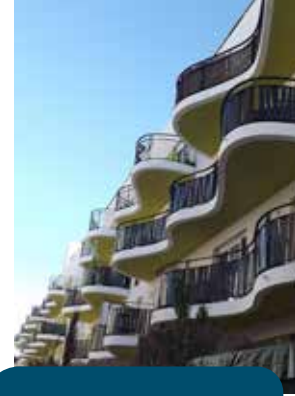
HABITAT ET LOGEMENT
